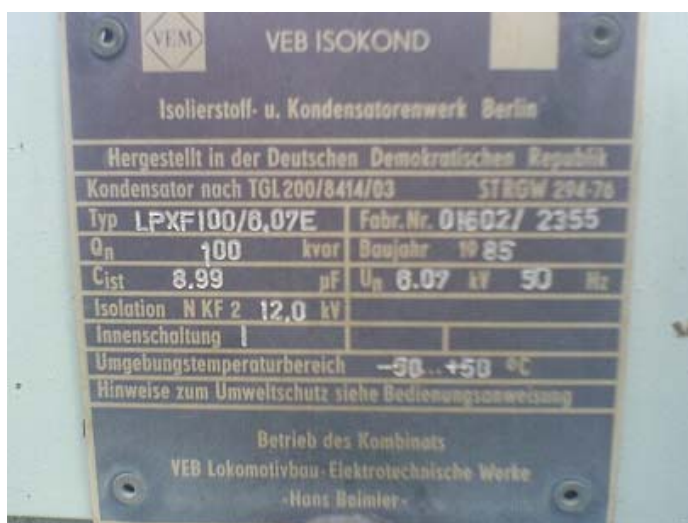
Снимка 4: Фабрична табела на немски РСВ кондензатор (градска подстанция), експлоатиран в България
