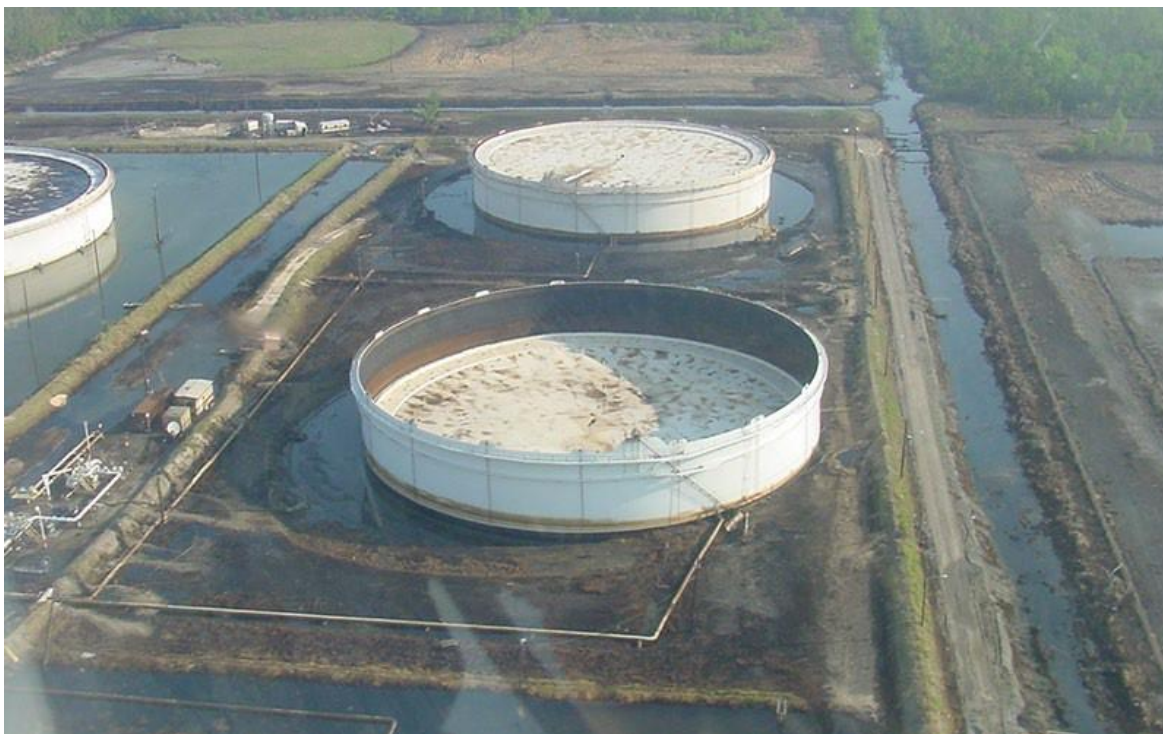
Фигура 9. Изместване и повреда на резервоар за съхранение при атмосферни условия, причинено от ураган, включително изместване на тръба.
