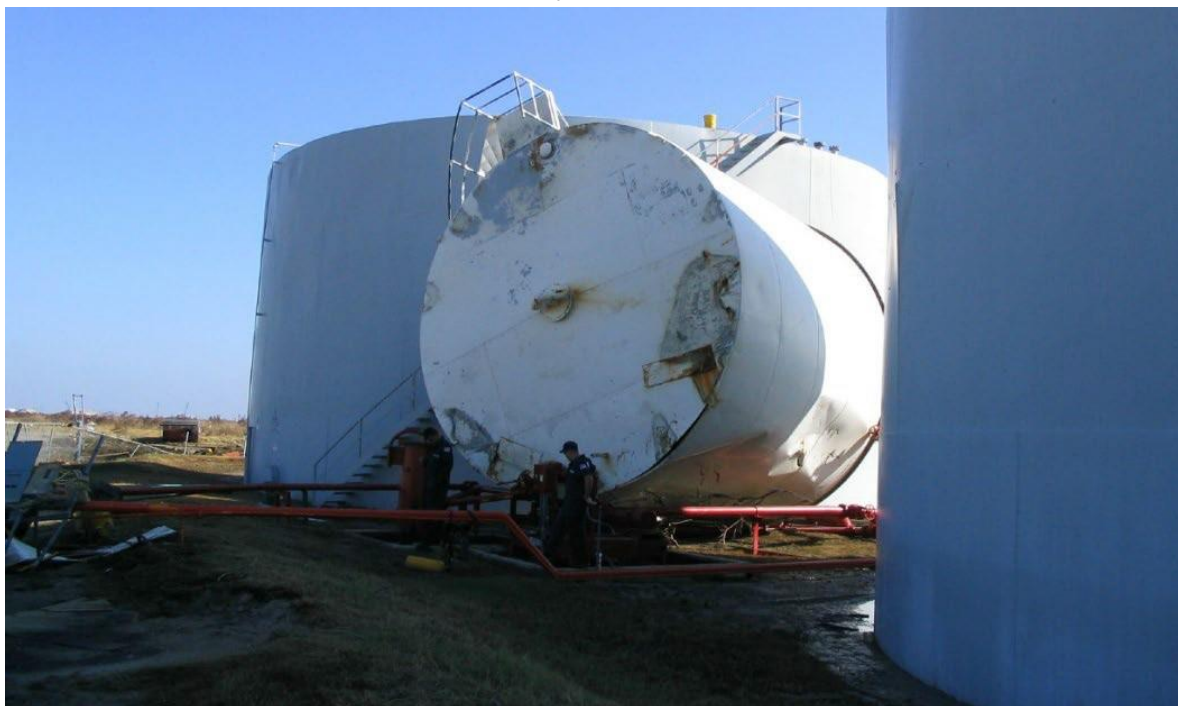
Фигура 10. Преобърнат и повреден резервоар за съхранение при атмосферни условия поради буря от ураган.
