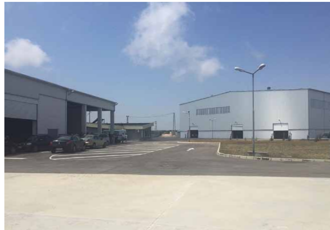
Претоварна станция за отпадъци, част от Регионалната система за управление на отпадъците в Добричкия регион Waste Transfer Station, part of the Regional Waste Management System in Dobrich Region
