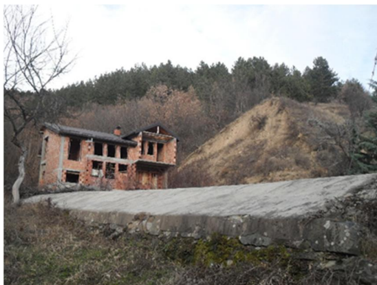
Фигура 24 Къща в строеж в непосредствена близост до трасето на раздел 3
