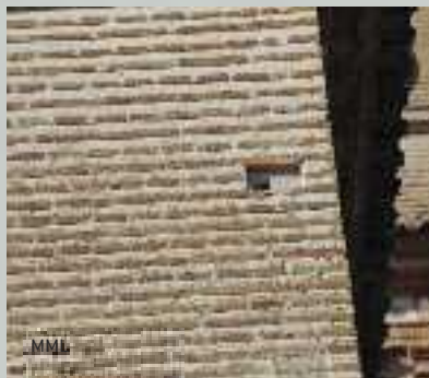
Reducción de mechinales aprovechando una restauración, para impedir el acceso a palomas
