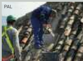
Apertura de hueco para introducir caja nido desde arriba
