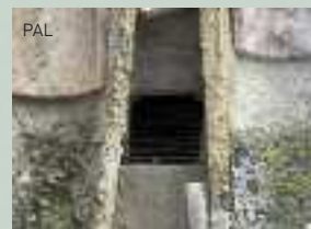
Aspecto del pasillo que conecta la teja de acceso con el agujero de entrada a la caja nido, y del modo en que se tapa con mortero la parte inferior y superior de este pasillo obligando al ave a entrar dentro de la caja y evitando que se mueva por el interior del resto del tejado. A la izquierda en teja portuguesa y a la derecha en teja árabe.
