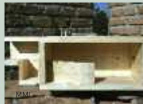
Armazón de madera con pasillo de entrada en recodo, que dificulta el acceso a depredadores como gatos, ginetas y garduñas (no impide por completo la entrada de garduñas). Este armazón será embutido en un muro de mampostería de ladrillo quedando integrado en el edificio
