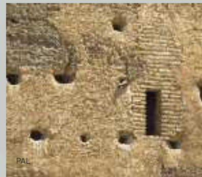
Adecuación de entrada a mechinales mediante piezas prefabricadas, en una colonia con problemas de competencia con palomas y grajillas
