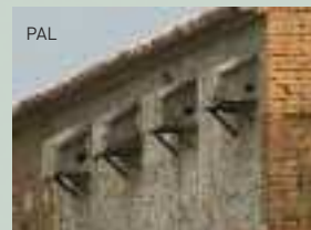
Batería de nidales de obra apoyados sobre estructuras metálicas instalados en el muro de un cortijo
