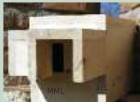
Armazón de madera con pasillo de entrada en recodo, que dificulta el acceso a depredadores como gatos, ginetas y garduñas (no impide por completo la entrada de garduñas). Este armazón será embutido en un muro de mampostería de ladrillo quedando integrado en el edificio
