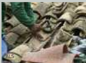
Recorte de los bordes de las tejas cóncavas en las esquinas inferiores, creando un pasillo nunca inferior a los 8-10cm de anchura
