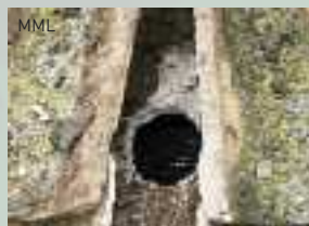
Recorte de los bordes de las tejas cóncavas en las esquinas inferiores, creando un pasillo nunca inferior a los 8-10cm de anchura
