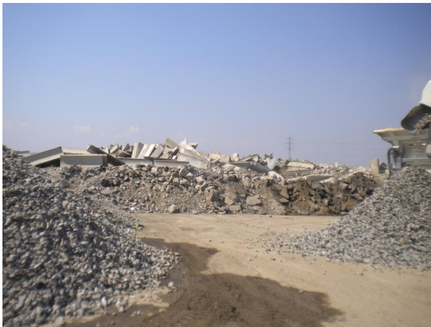
Фиг.10. Бетонни строителни отпадъци от разрушение на мостово съоръжение (на заден план) и рециклиран трошен камък от бетонни отпадъци (на преден план).
